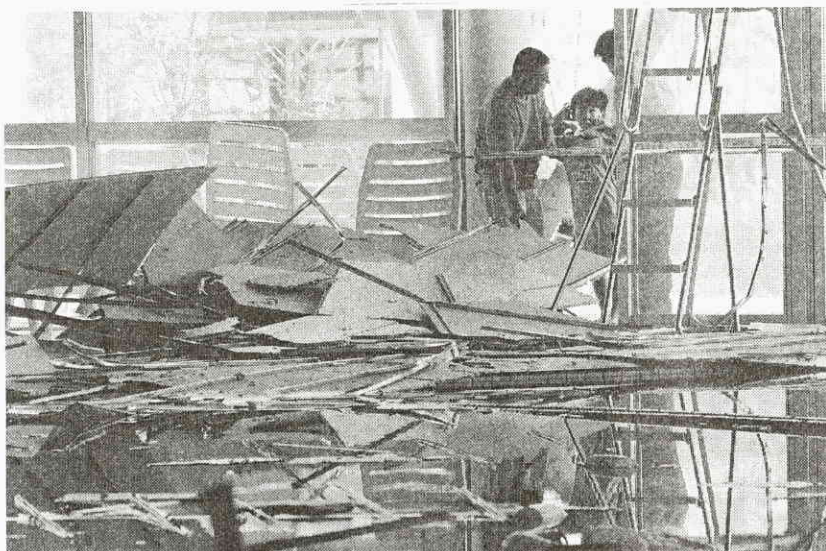
地震によって崩れ落ちたプールの天井（16日午後1時過ぎ、仙台市東区の「スポパーク松森」で）
