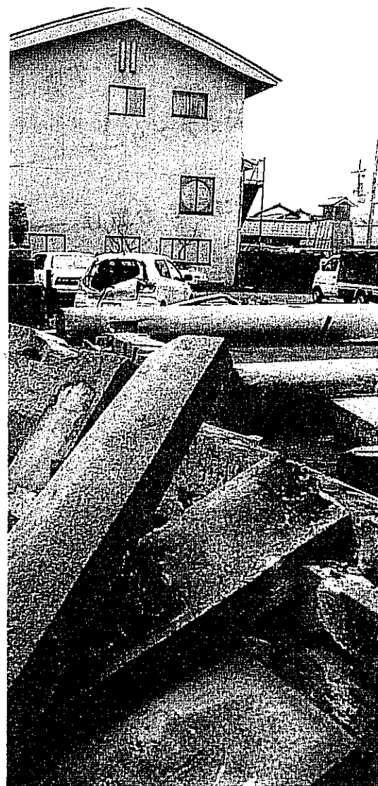
倒壊した重蔵神社の鳥居（25日午前10時10分、輪島市河井町で）＝川嶋路大撮影
