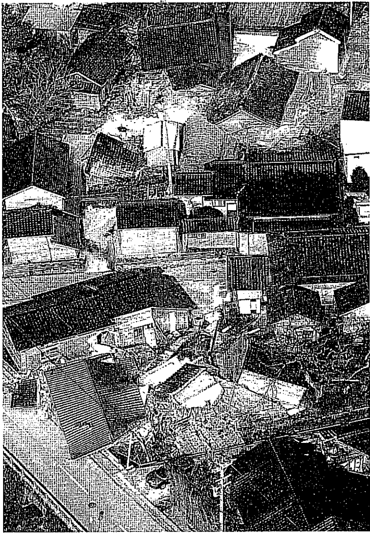
地震で倒壊した多くの民家(25日午後3時1分、石川県輪島市で、本社ヘリから)＝上田尚紀撮影
