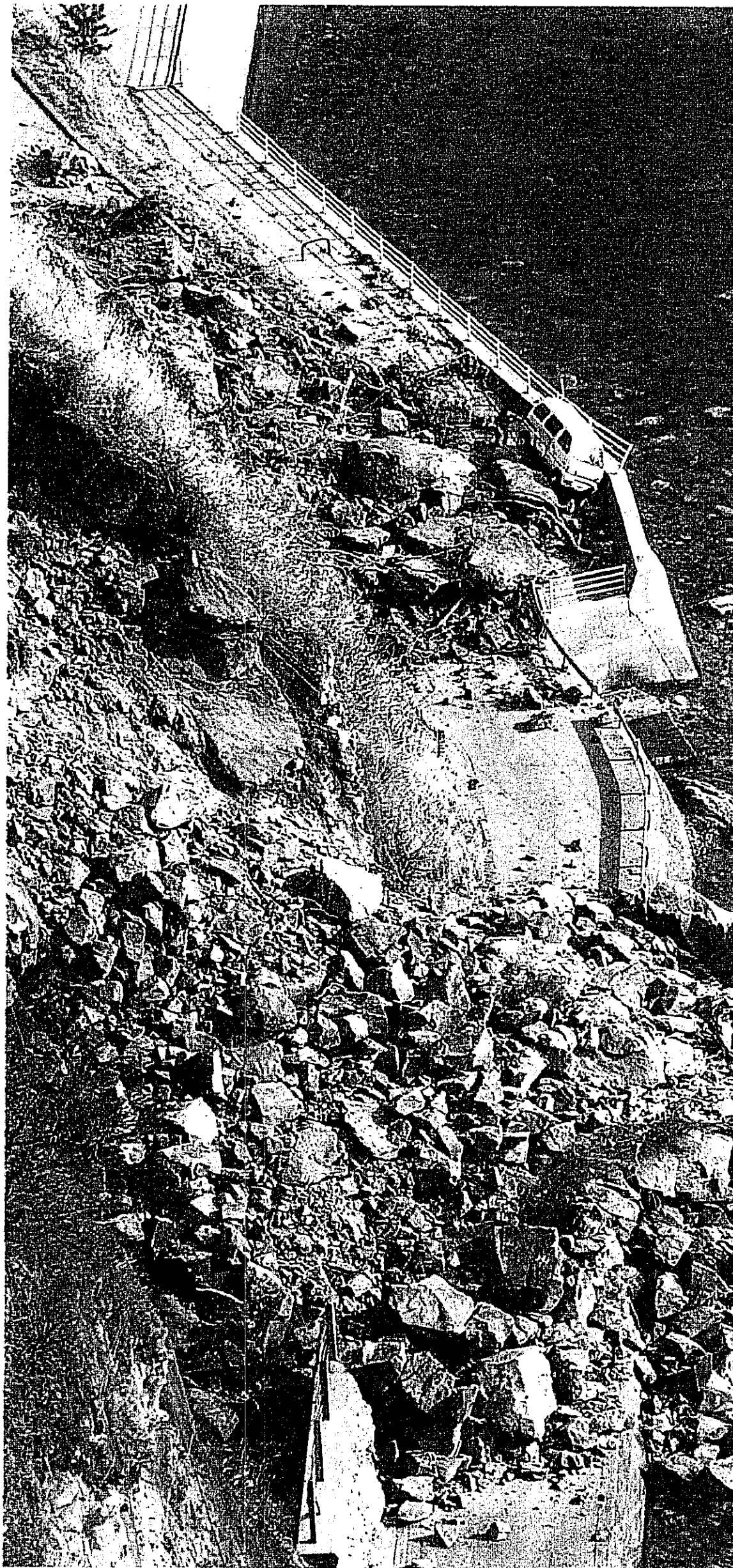
崩れた土砂で車が横転した現場(25日午後3時34分、石川県輪島市で、本社へりから)＝上田尚紀撮影
