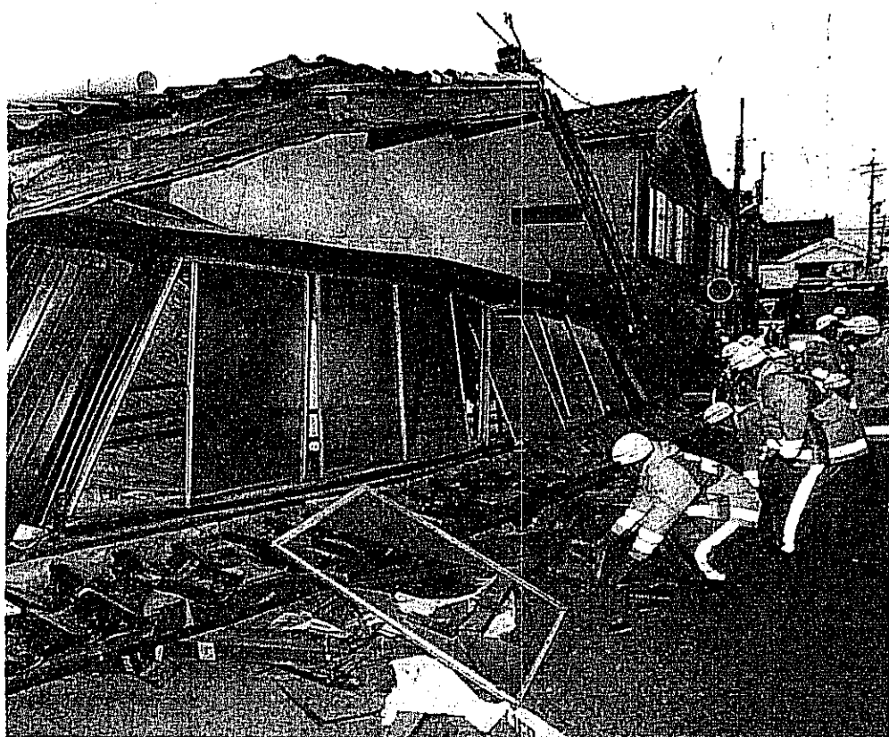
倒壊した家屋から危険なガラス窓などを取り外す機動隊員ら（25日午後6時12分、輪島市河井町で）＝河村道浩撮影
