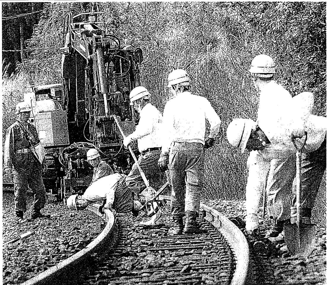
地震でゆがんだ線路の復旧工事を行う作業員(28日午前9時半、石川県穴水町ののと鉄道)＝鈴木毅彦撮影
