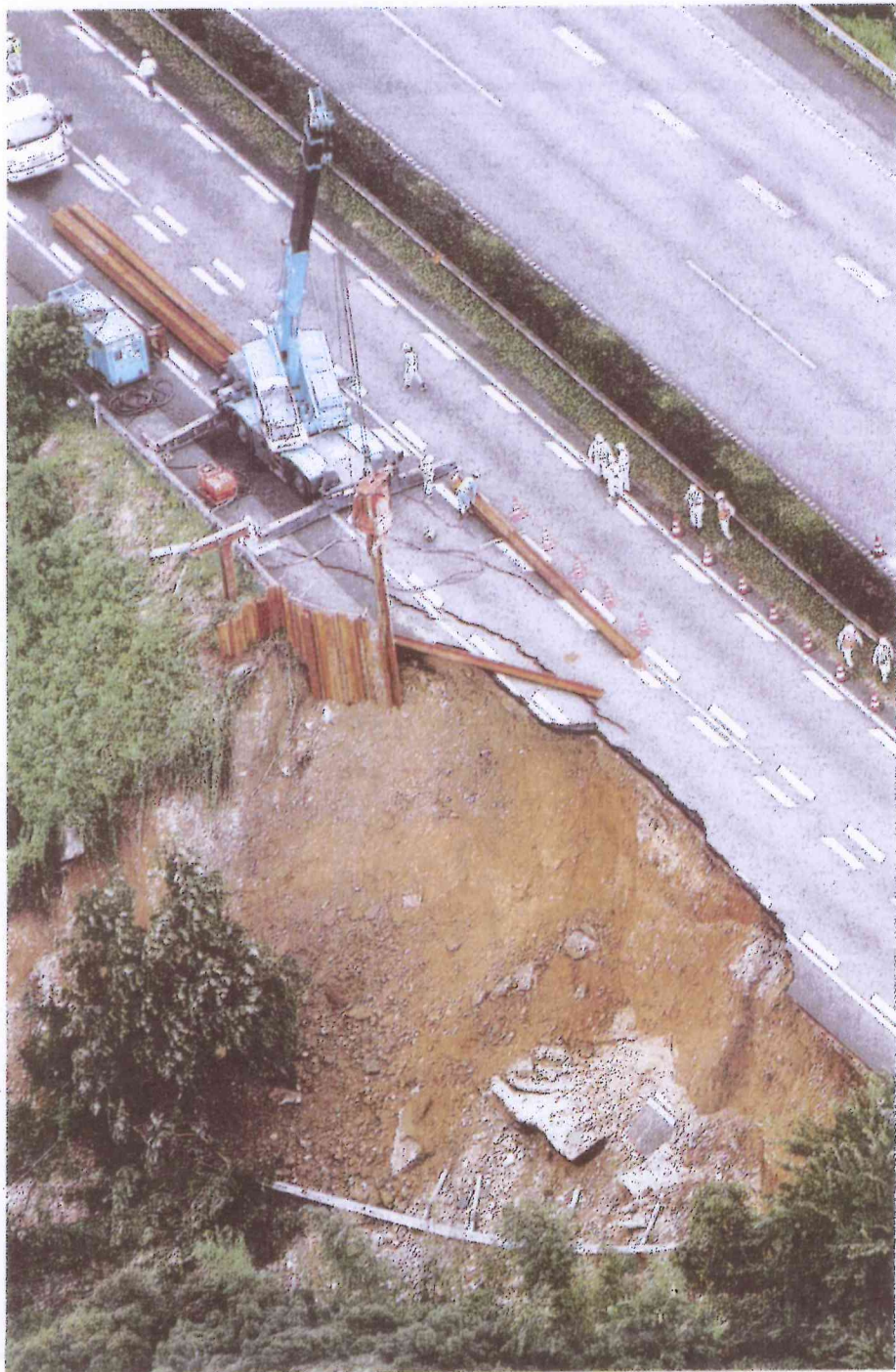
東名高速道路の路面崩落現場での復旧作業 (11日午後4時46分、静岡県牧之原市で、 本社ヘリから)＝川口正峰撮影
