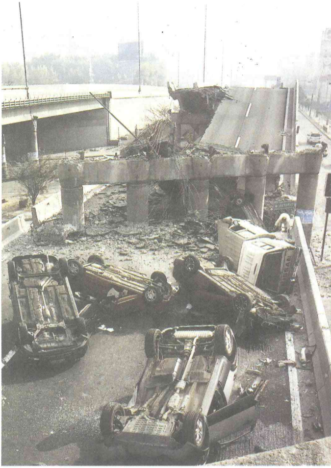
27日、チリの首都サンティアゴ近郊で走行中に高架道路が崩壊し、ひっくり返った車(ロイター)
